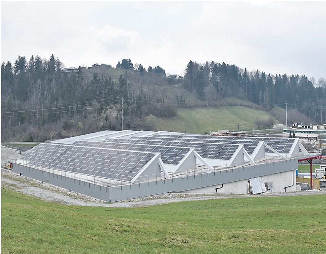
Liefert überdurchschnittlich viel Energie: die im Vorjahr in Betrieb genommene Solaranlage auf dem Dach des Steinauer-Recyclingcenters. Foto: Patrizia Pfister
